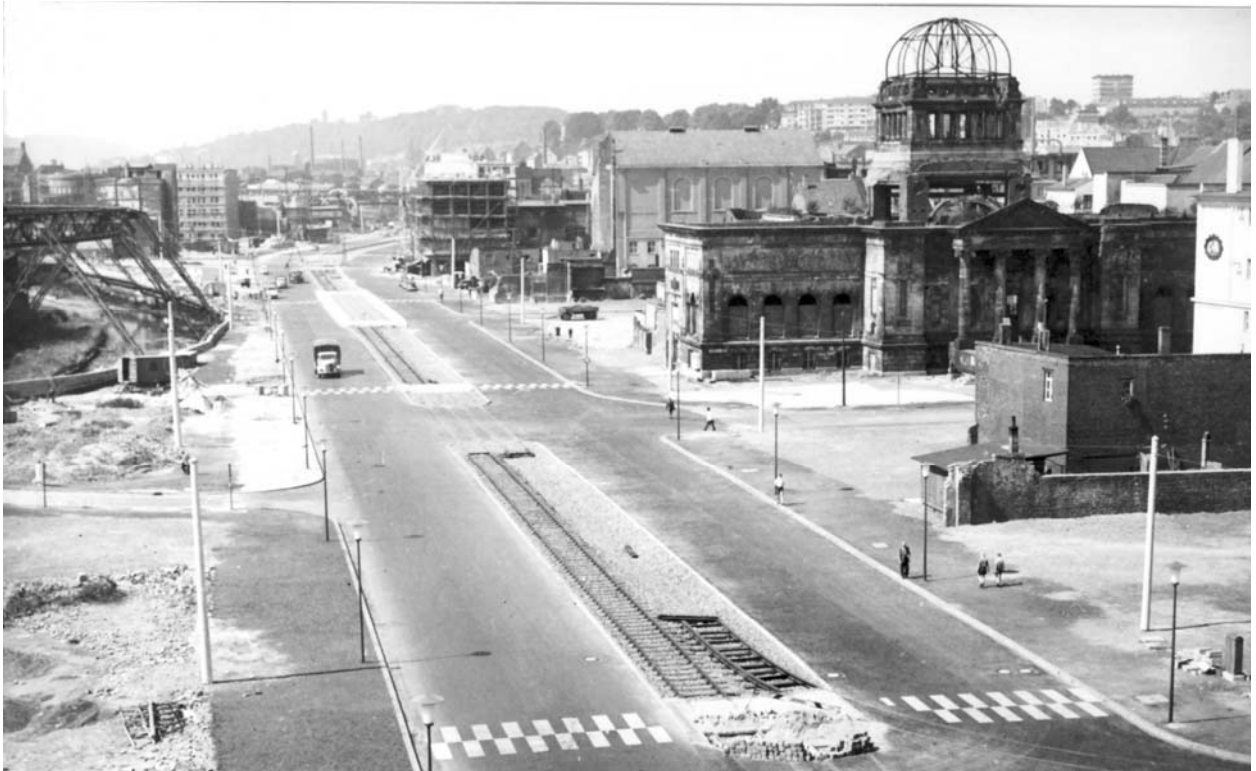
Die neue Höhe 1953 mit der Ruine der Ruhmeshalle
